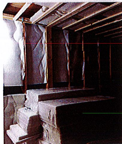
👉 防音室の施工中写真
